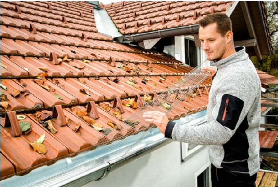
Bildtext: Die Montage des GRÖMO Laubschutzgitters ist einfach: auf die benötigte Länge zuschneiden und in die Dachrinne einlegen.
