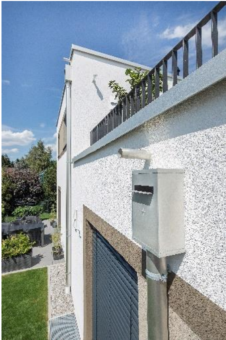
Bildtext: Mit einer Tiefe von 150 mm trägt der Wasserfangkasten an der Fassade kaum auf.
