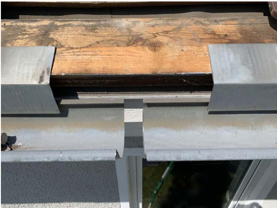
**Bildtext:** *Für die Installation der Dilatation wurden zunächst die bestehenden Dachrinnen jeweils in der Mitte zwischen zwei Rinnenhaltern getrennt*
