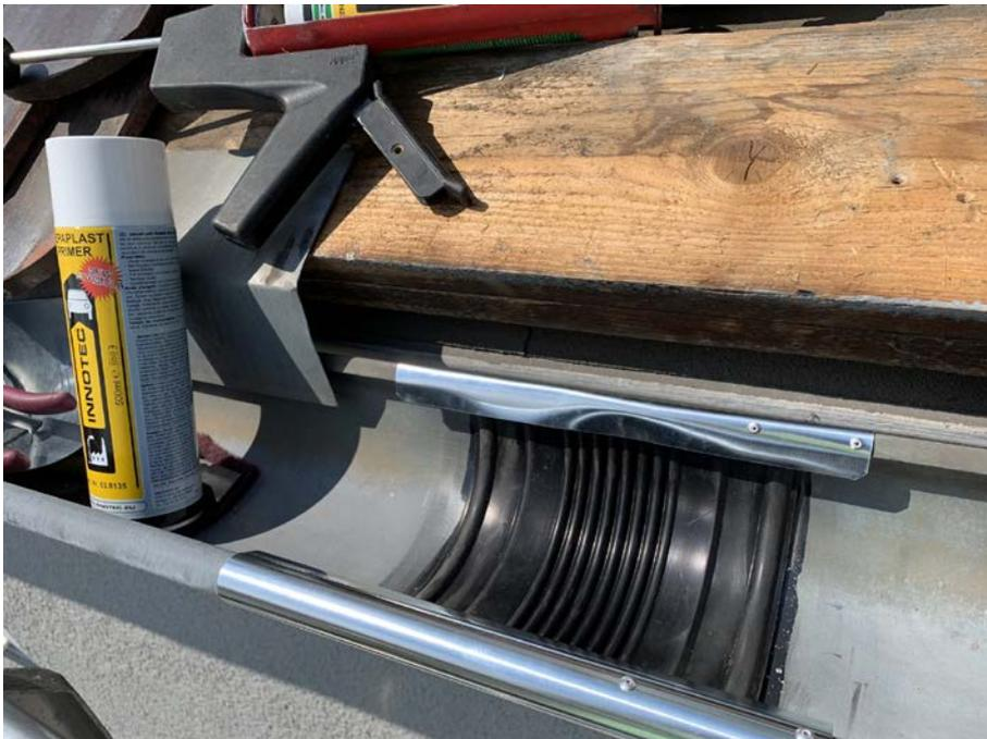
**Bildtext:** Durch die Wulstblende wird das Niederschlagswasser in die Rinne geleitet und kann nicht hinter den Bewegungsausgleicher eindringen
