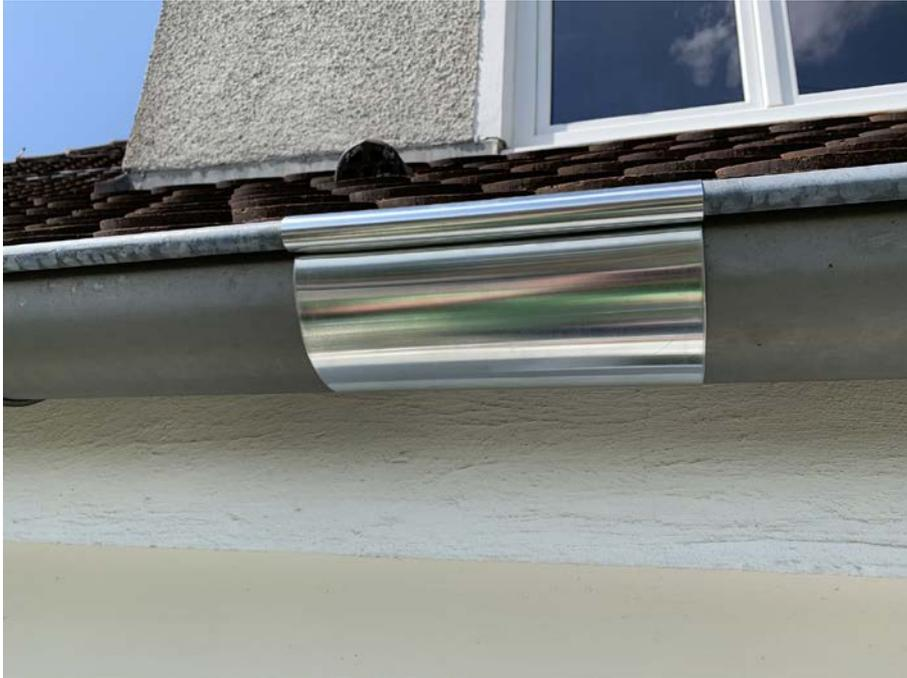
**Bildtext:** Eine Rinnenblende sorgt für eine einheitliche Optik am Dach. Zusätzlich dient sie als Auflagefläche für den Gummi, um ein Durchhängen des Wellenprofils zu vermeiden
