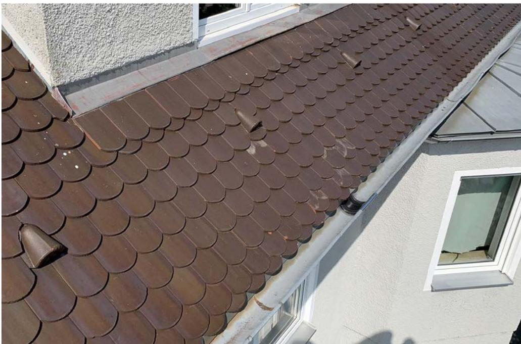
**Bildtext:** Die neu eingebauten Bewegungsausgleichselemente lassen in Zukunft keine Spannungen mehr in der Rinne aufkommen.
