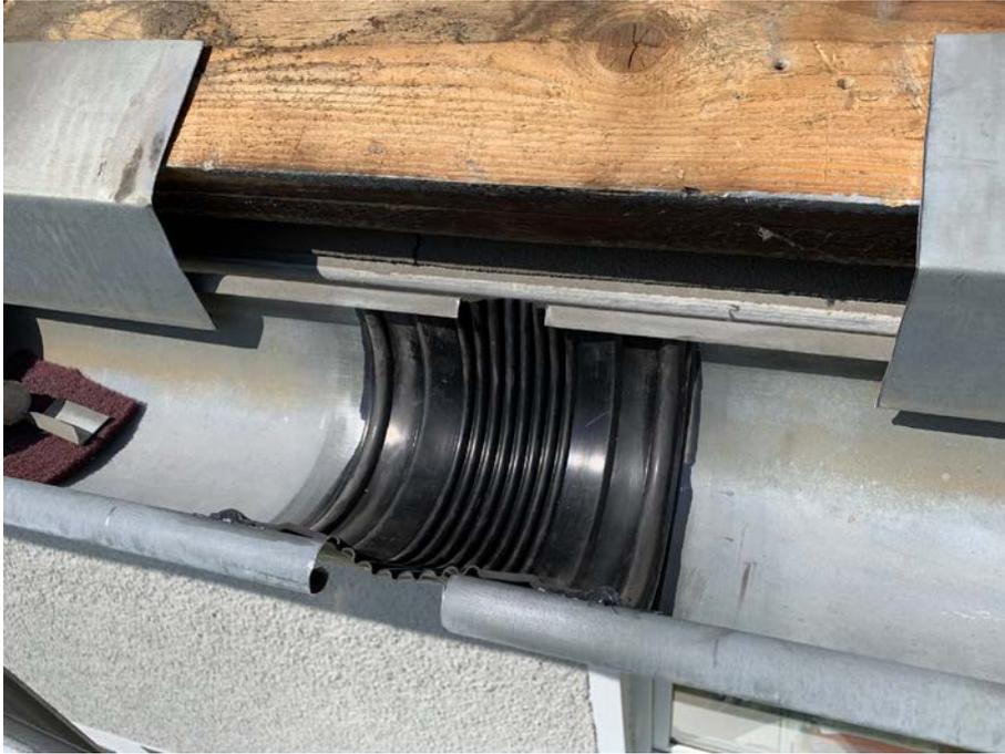
**Bildtext:** Die Universal-Rinnendilatation wurde mittig über dem Auslass positioniert und verklebt
