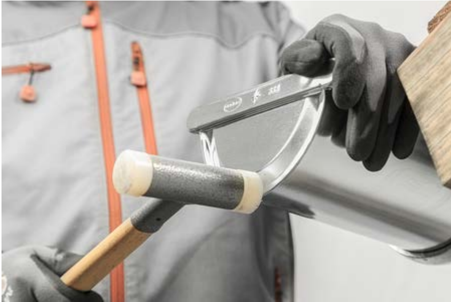
Bildtext: Der Bördeboden wird nach dem Anreifen der Rinne mit dem Hammer aufgeklopft
