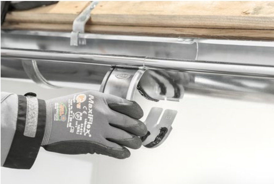
Bildtext: Der Rinnenverbinder wird über die überlappende Rinnennaht geklebt und verbindet so im Nu zwei Rinnen
