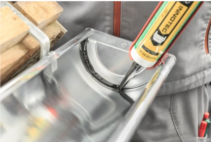
Bildtext: Der Steckrinnenboden wird mit Klebstoff an der Dachrinne fixiert.
