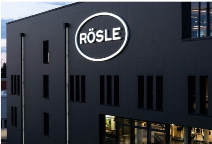
Bildtext: LED-Fallrohrbeleuchtung an einem Industriegebäude
